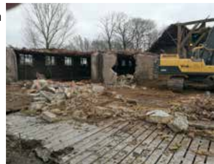
De afbraakwerkzaamheden zoals Johannes Groen het zelf vastlegde.
